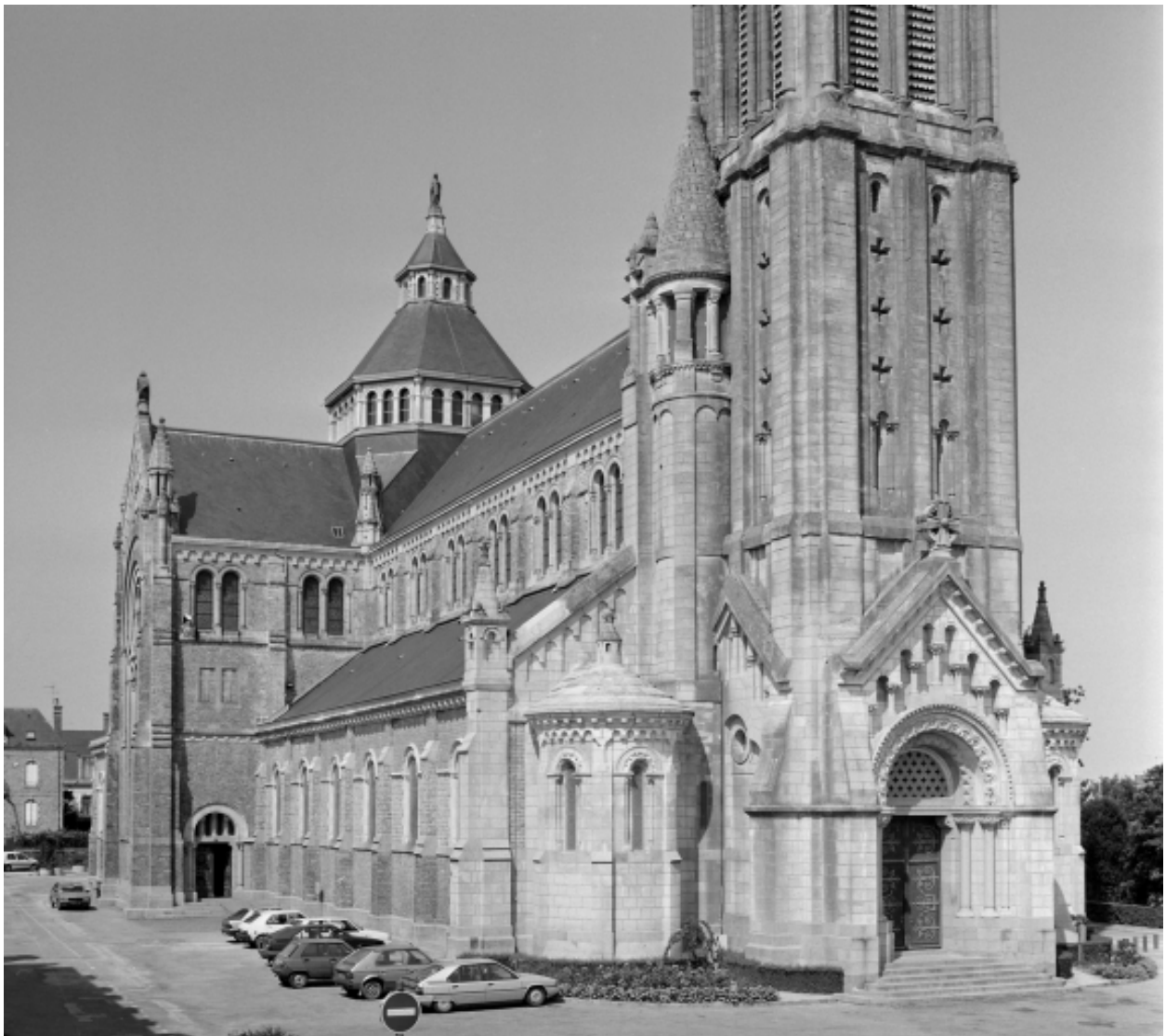
Elévation Sud-Ouest : vue générale
