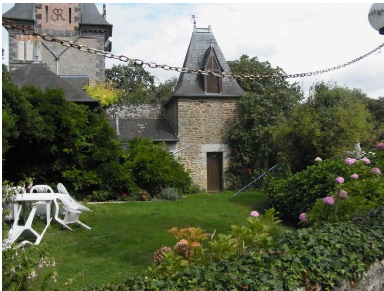
Vue latérale sud-ouest du logis, souche de cheminée SR, pavillon de jardin
