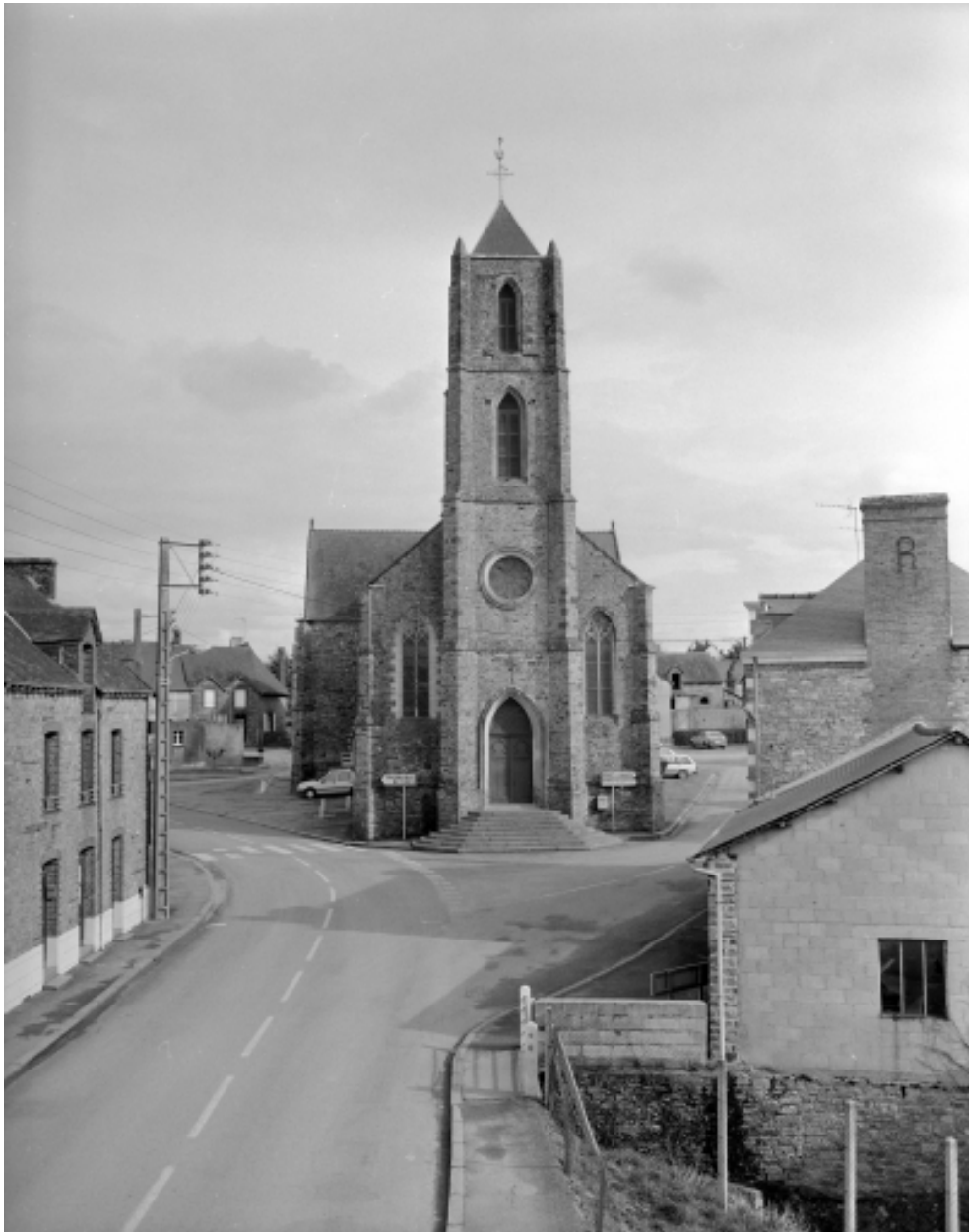
Elévation ouest : vue générale
