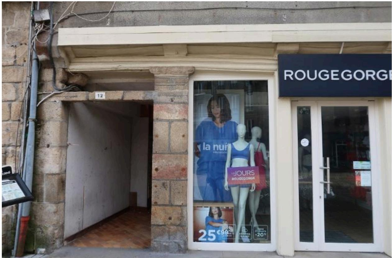
Le rez-de-chaussée maçonné supporte l'encorbellement de l'étage, composé de deux sablières et d'entretoises moulurées.
