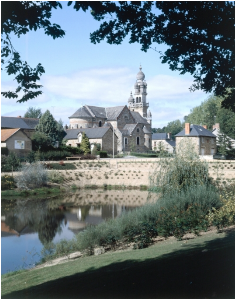
Elévation Sud-Est : vue générale
