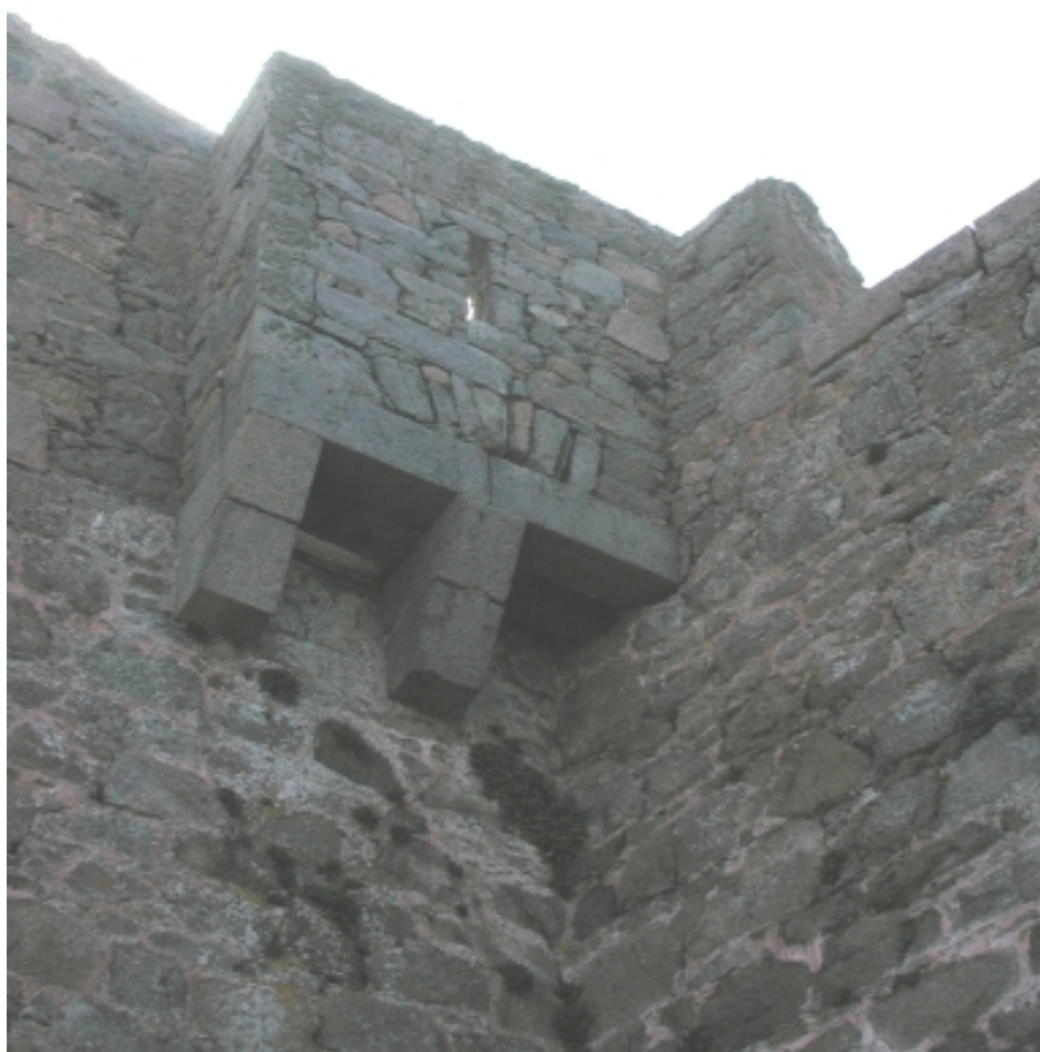
Façade nord : vue de la brèche flanquant le pont-levis de la redoute, réduit (assemblage des pierres en quinconce)
