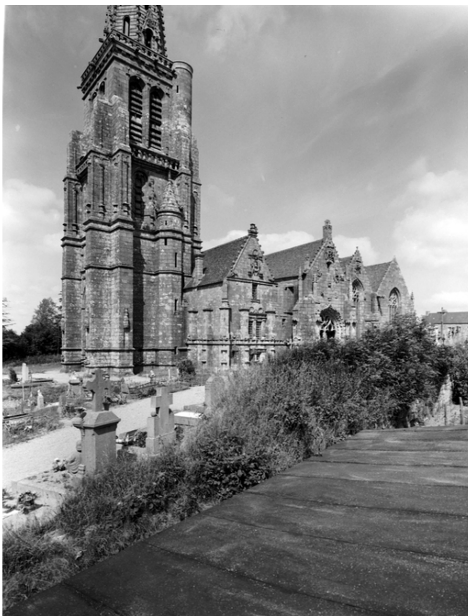
Tour ouest : vue générale sud-ouest
