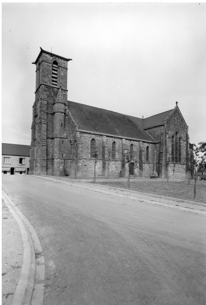
Vue générale du sud-ouest
