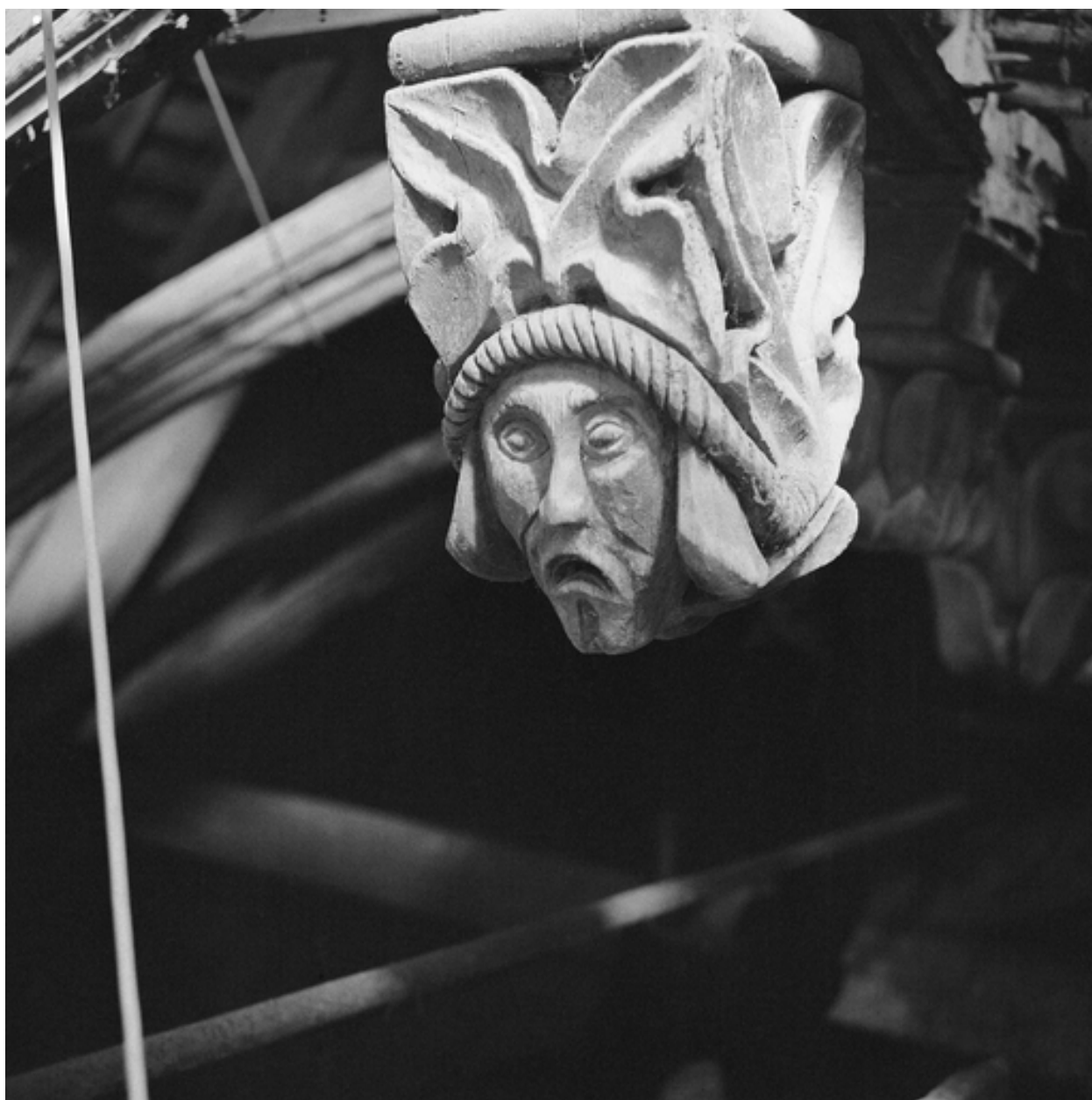
Charpente, détail de la clé 26.
