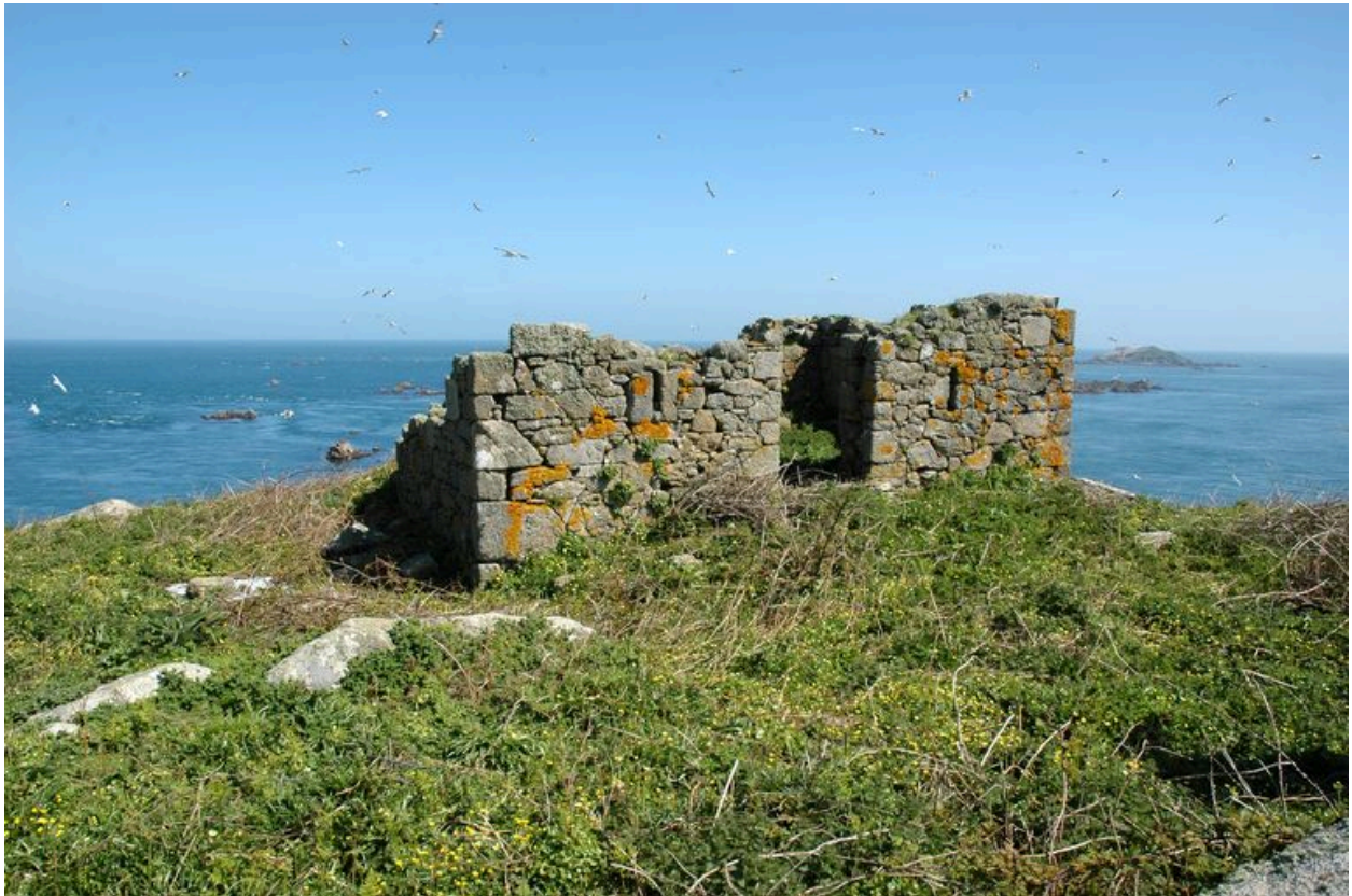
Vue du corps de garde de l'Île Bono (état en 2006)
