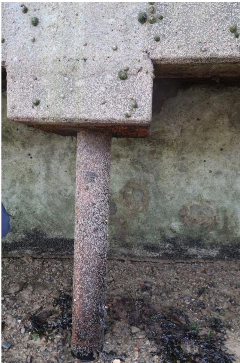
Cale de l'île aux moutons, détail des pieux soutenant l'élargissement de l'infrastructure
