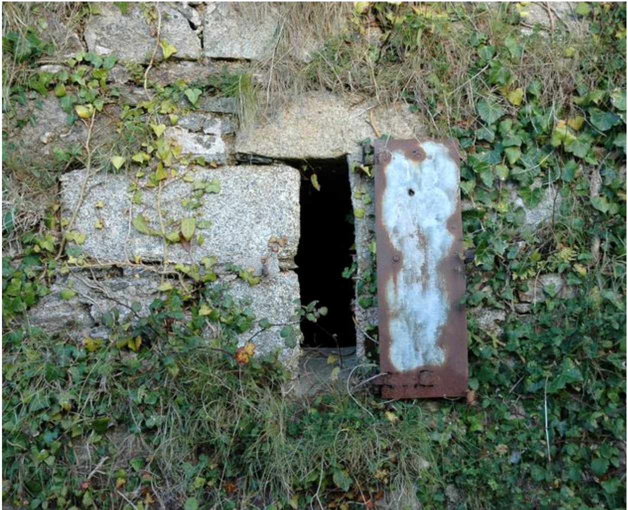
Vue de l'un des créneaux de tir permettant la défense du fossé sec (état en 2004). Il a conservé son volet métallique
