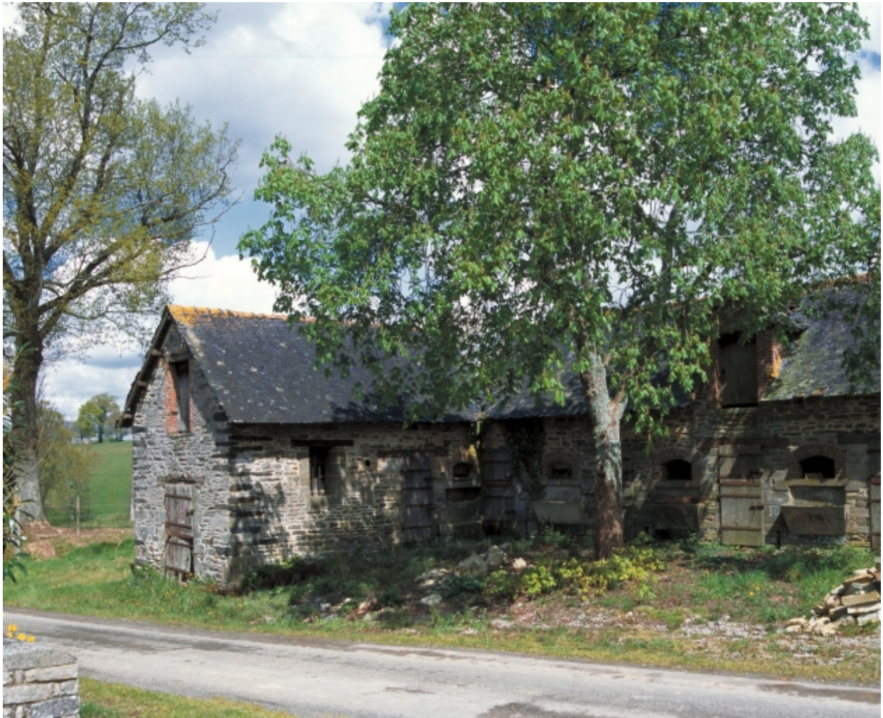
Les soues à porcs : vue générale sud-ouest
