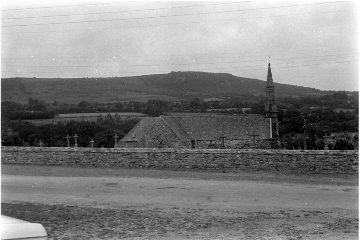
Saint-Rivoal, église paroissiale Saint-Rivoal : vue de situation depuis le nord. Etat en 1969
