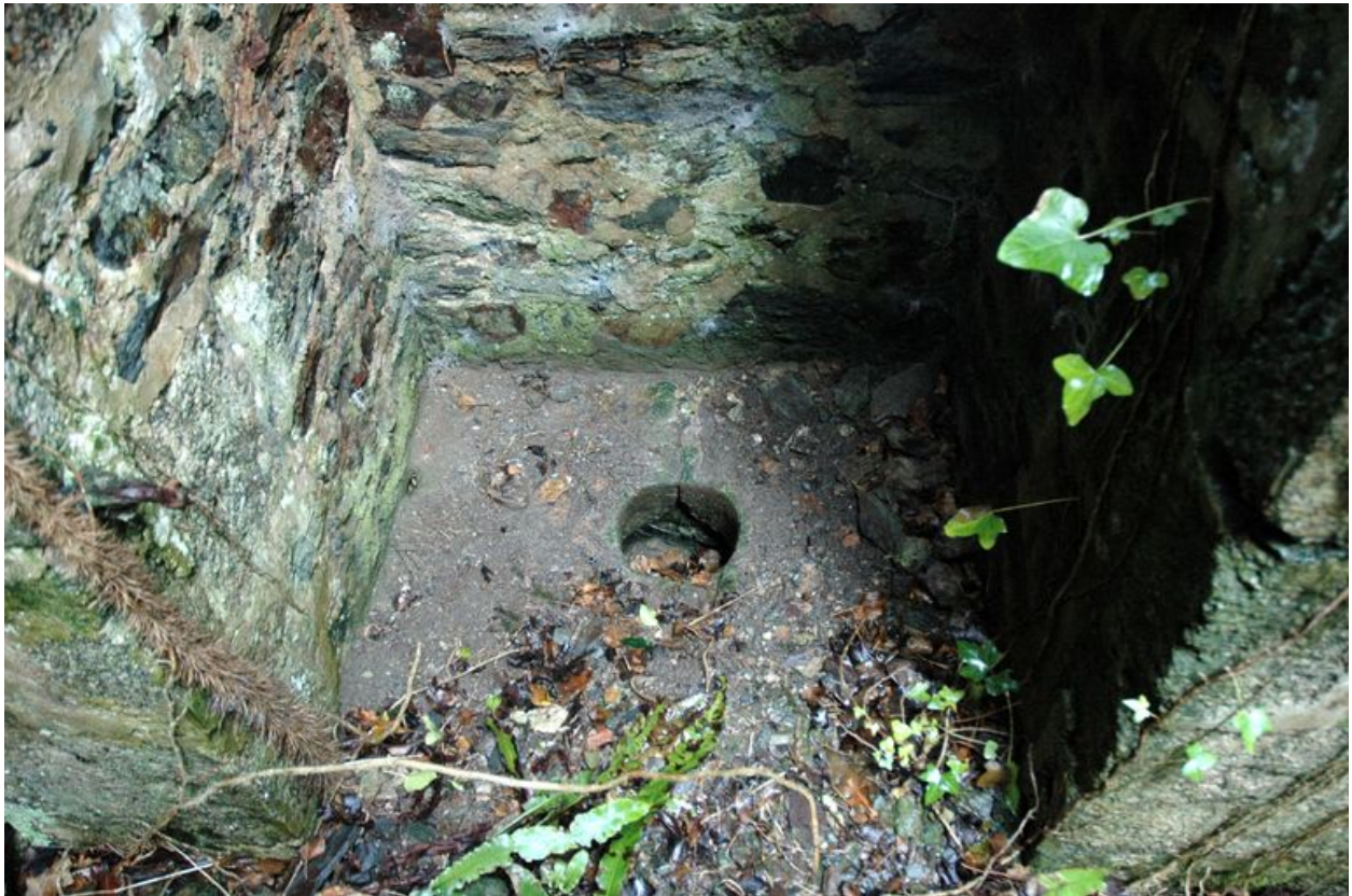
Vue de la caserne défensive Robert : créneau de fusillade ouest faisant fonction de latrines
