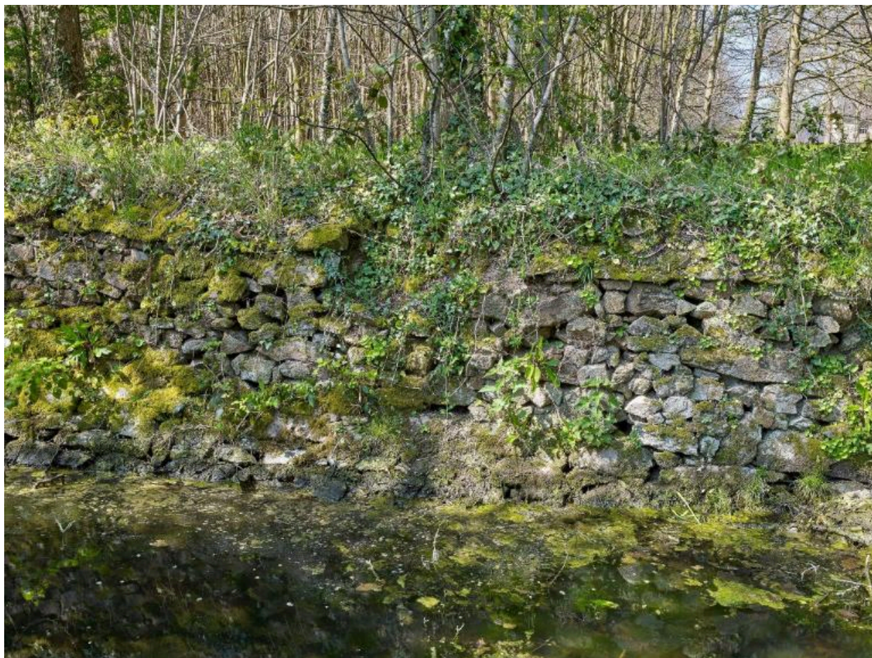
Canal d'alimentation des douves, vue rapprochée du mur en pierres sèches
