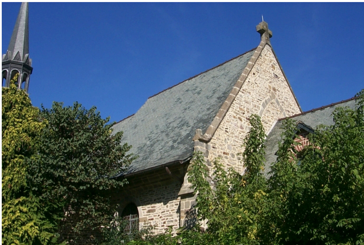
Vue générale sud-est, chevet
