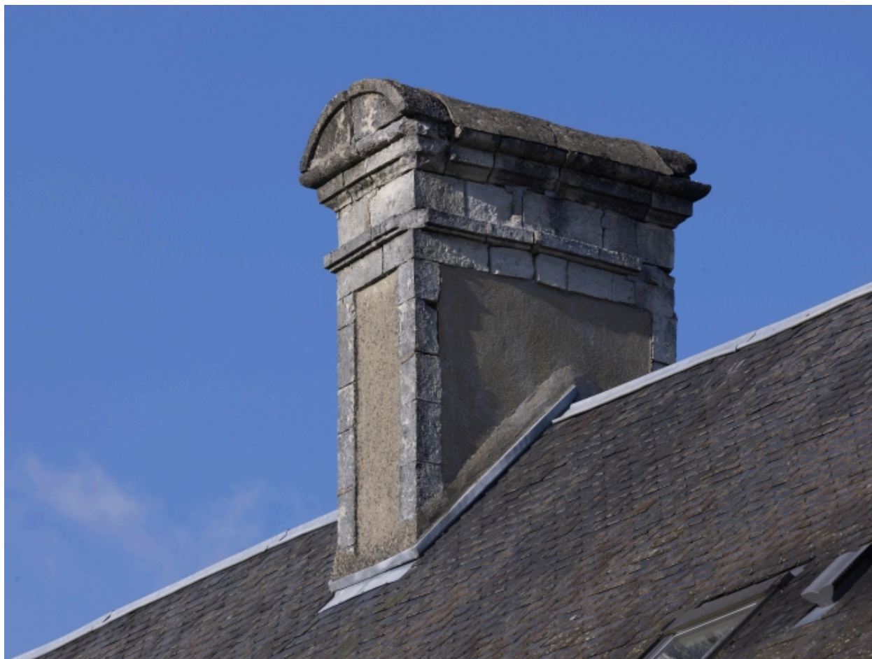
Corps principal, souche de cheminée
