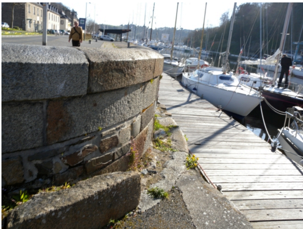
Vue du revers du banc, face au quai d'Aiguillon
