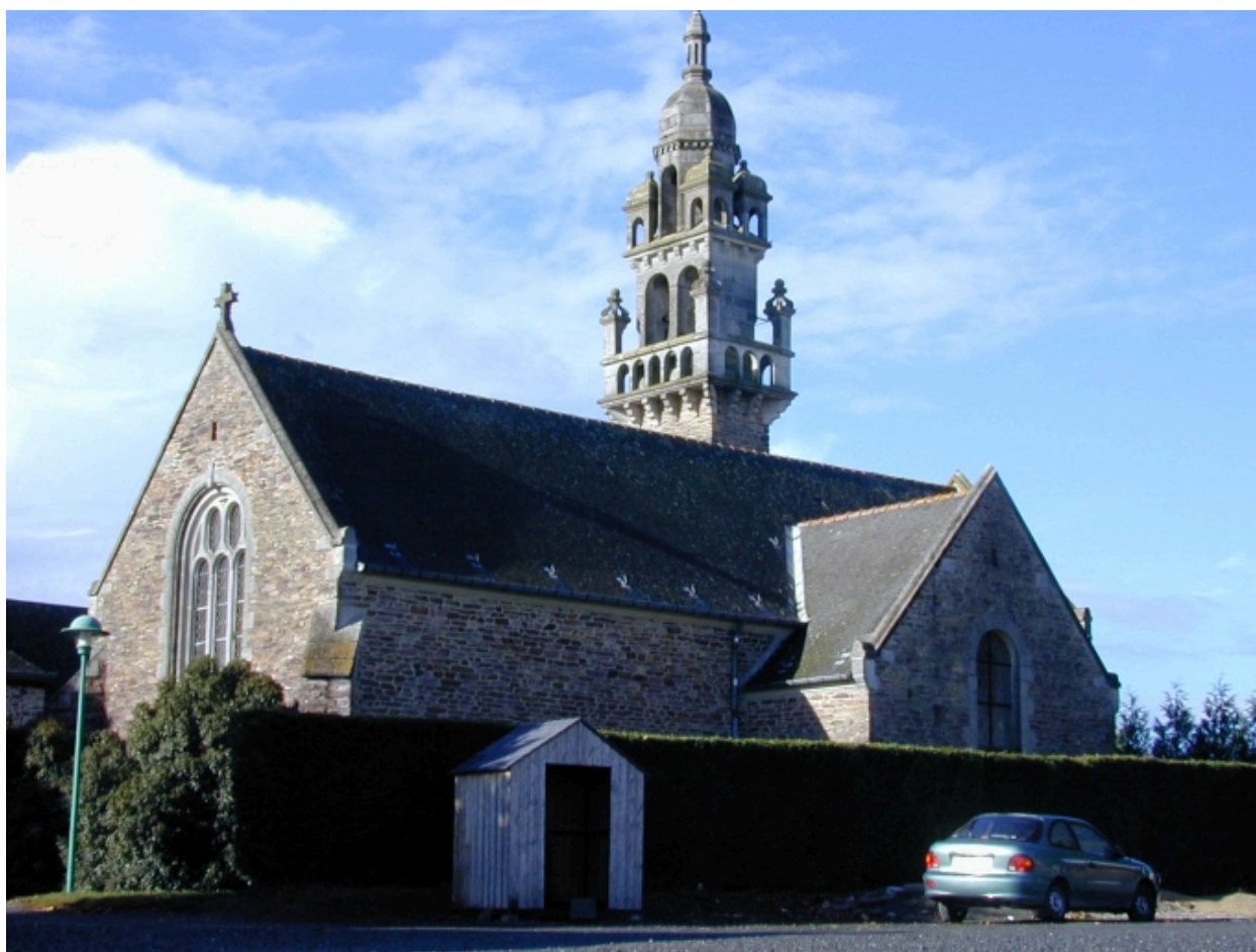
Vue générale sud-est de l'église
