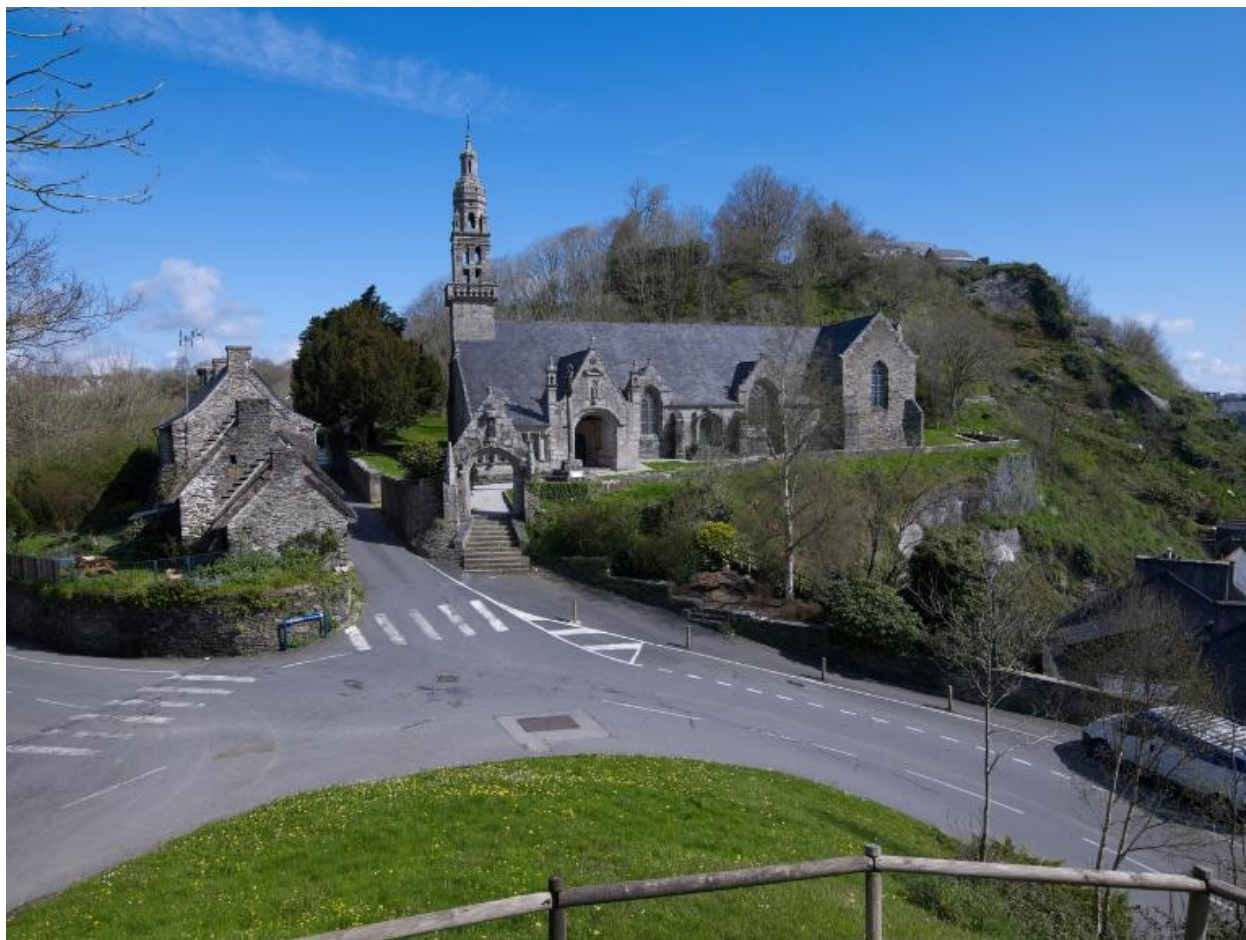
Vue générale, sud
