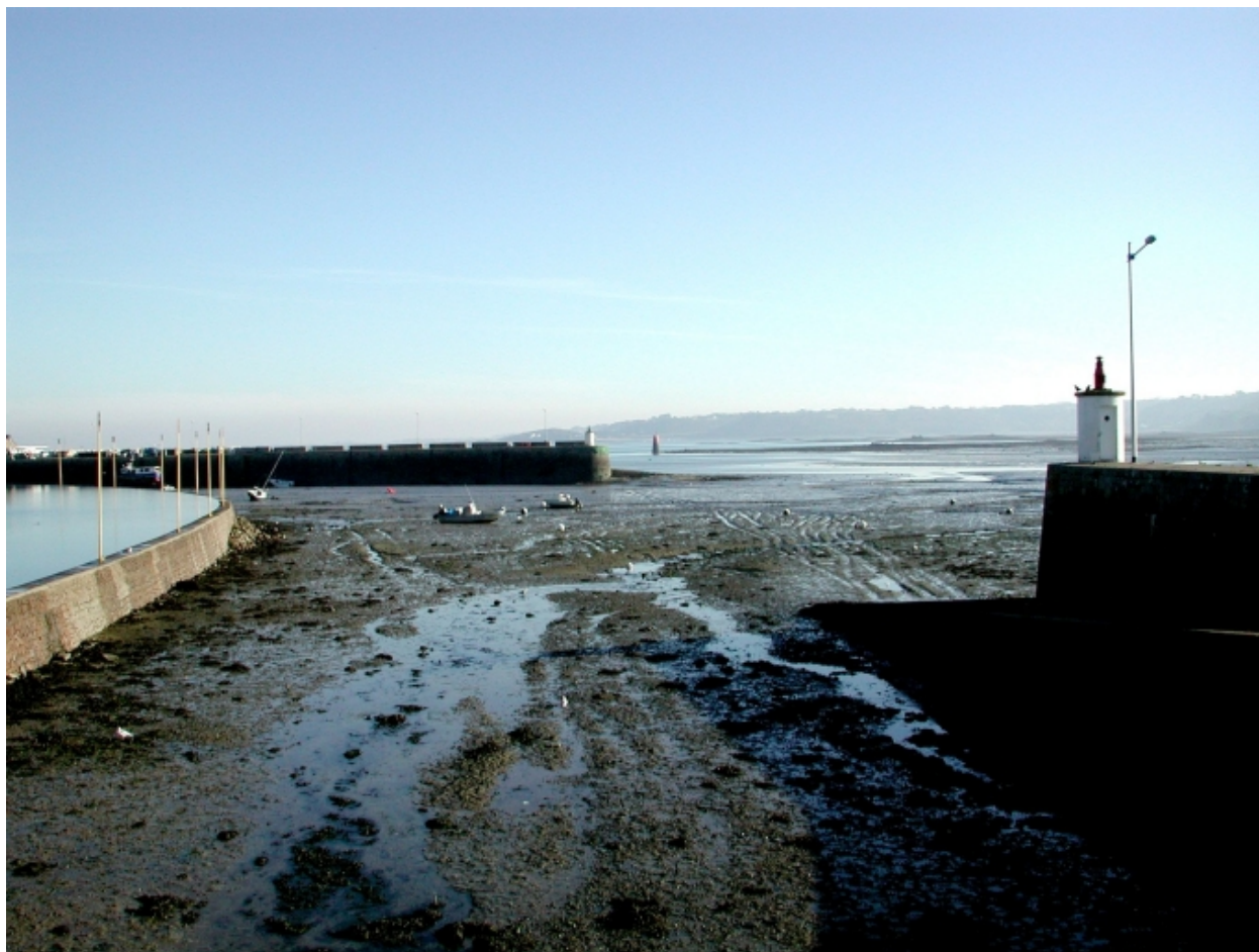
Vue générale des anciens ouvrages portuaires du 19ème siècle, à marée basse : la jetée du Linkin et la cale de l'Eperon (Collection particulière)
