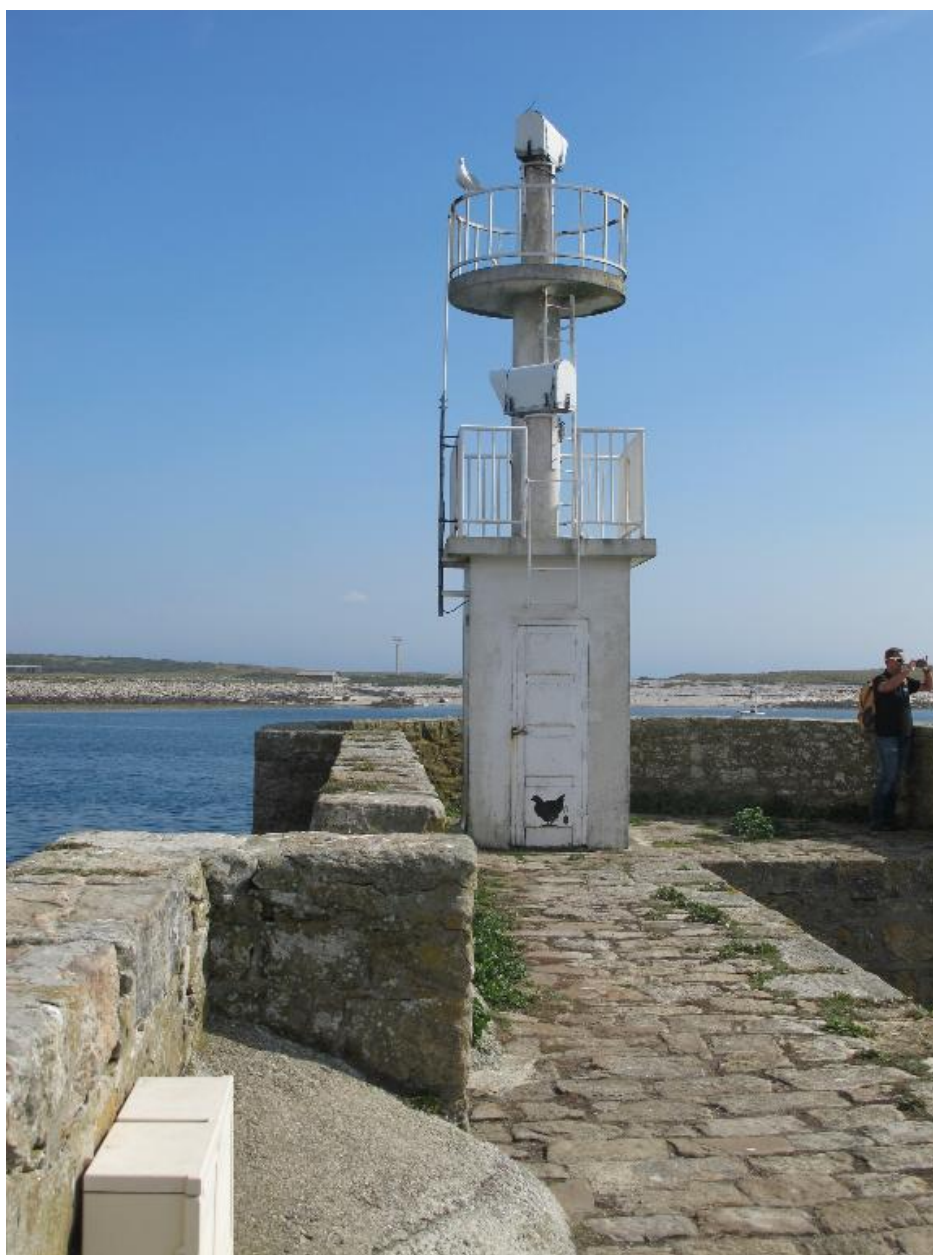
Le port, digue et signal
