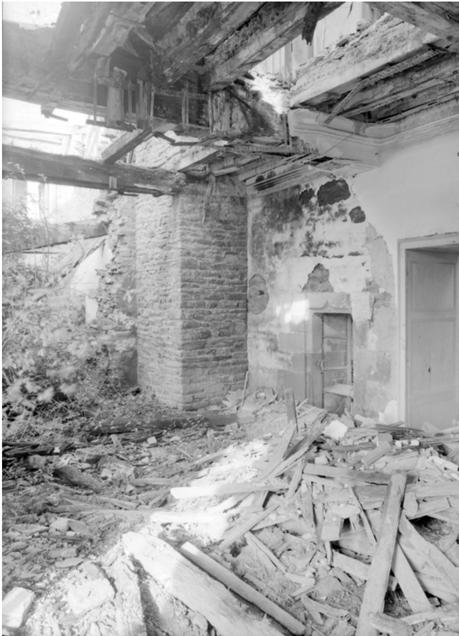
Rez-de-chaussée, pièce principale, état actuel, vue prise du sud-ouest.
