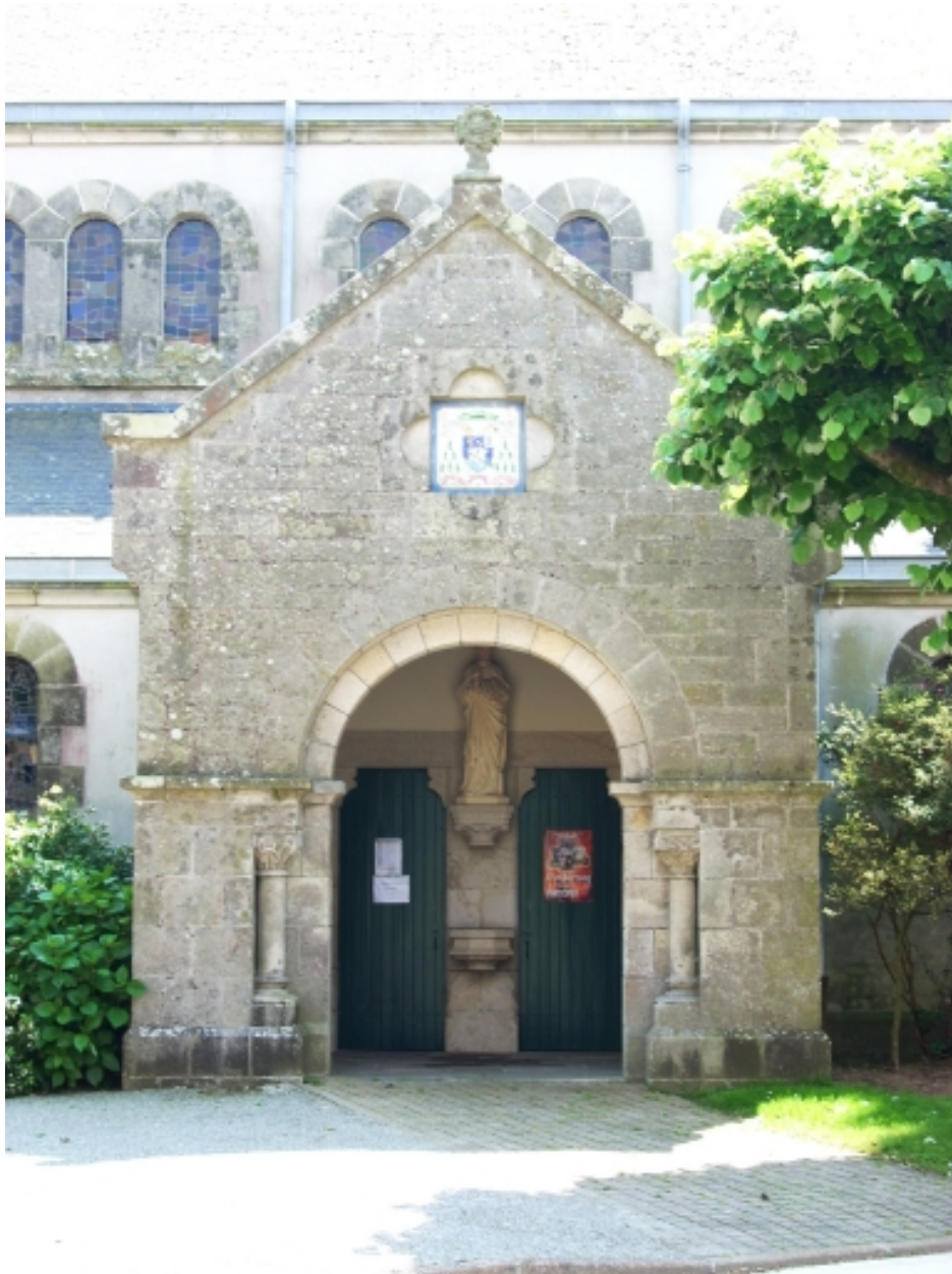
Plomelin, église paroissiale : porche sud
