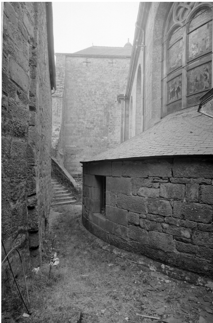
Façade sud : vue générale du choeur et de la sacristie prise du sud est
