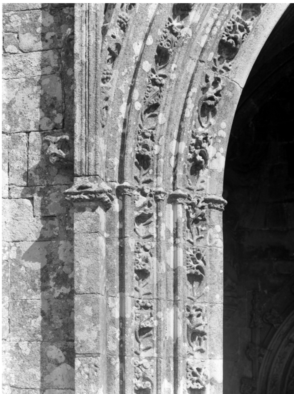
Porche, face sud : vue de l'embrasure ouest
