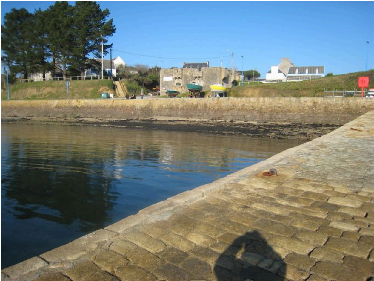
Partie du débarcadère au fond du port
