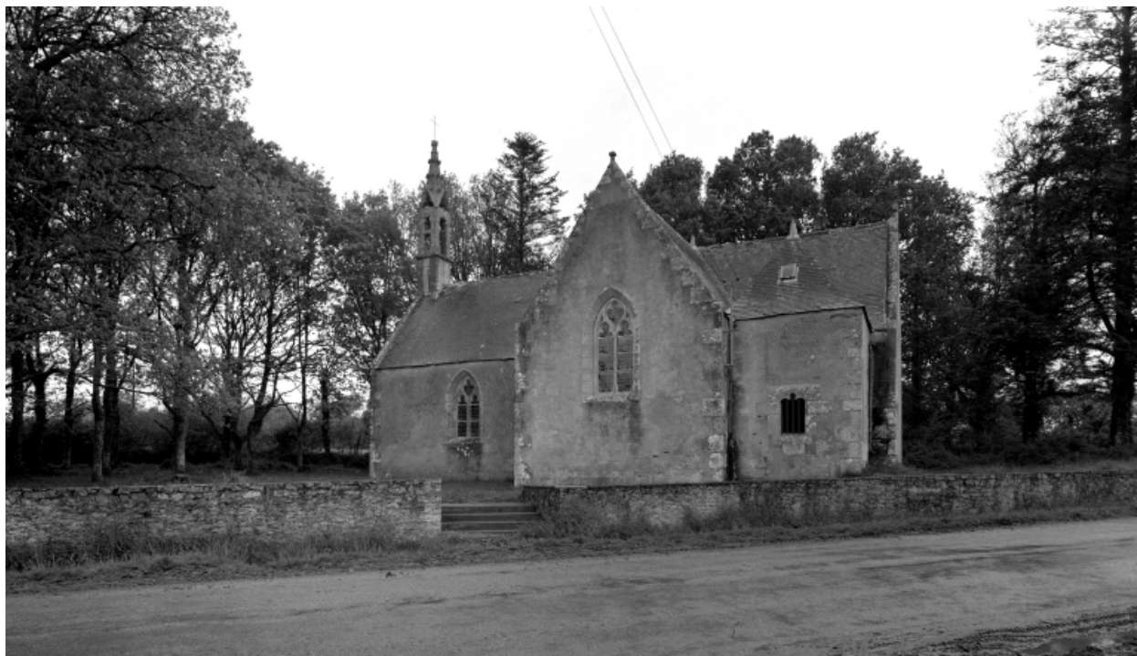
Collorec, chapelle Sainte-Marguerite : vue générale sud, état en 1967
