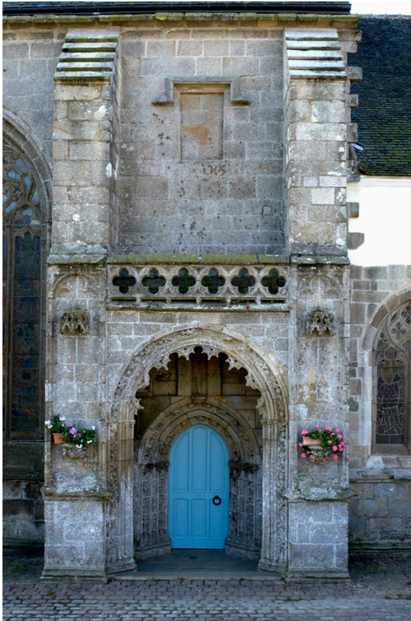
Vue de la travée du porche nord.
