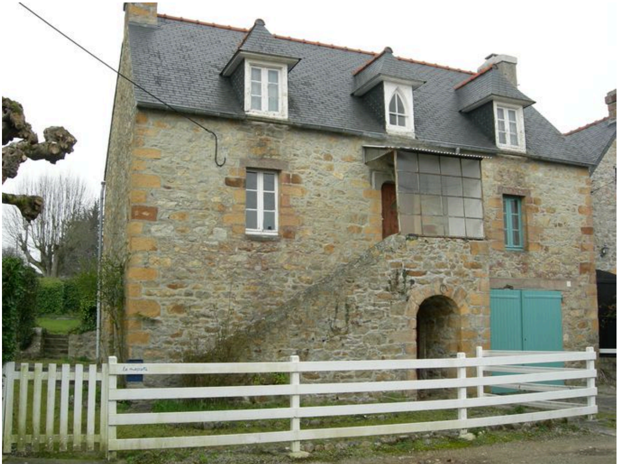
Vue générale de la villa Mascotte
