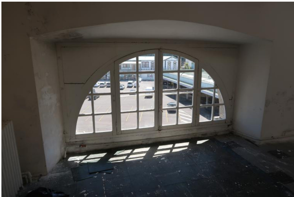
Vue intérieure : partie ouest, détail de l'une des baies à petits bois donnant vers le sud (état en 2022)
