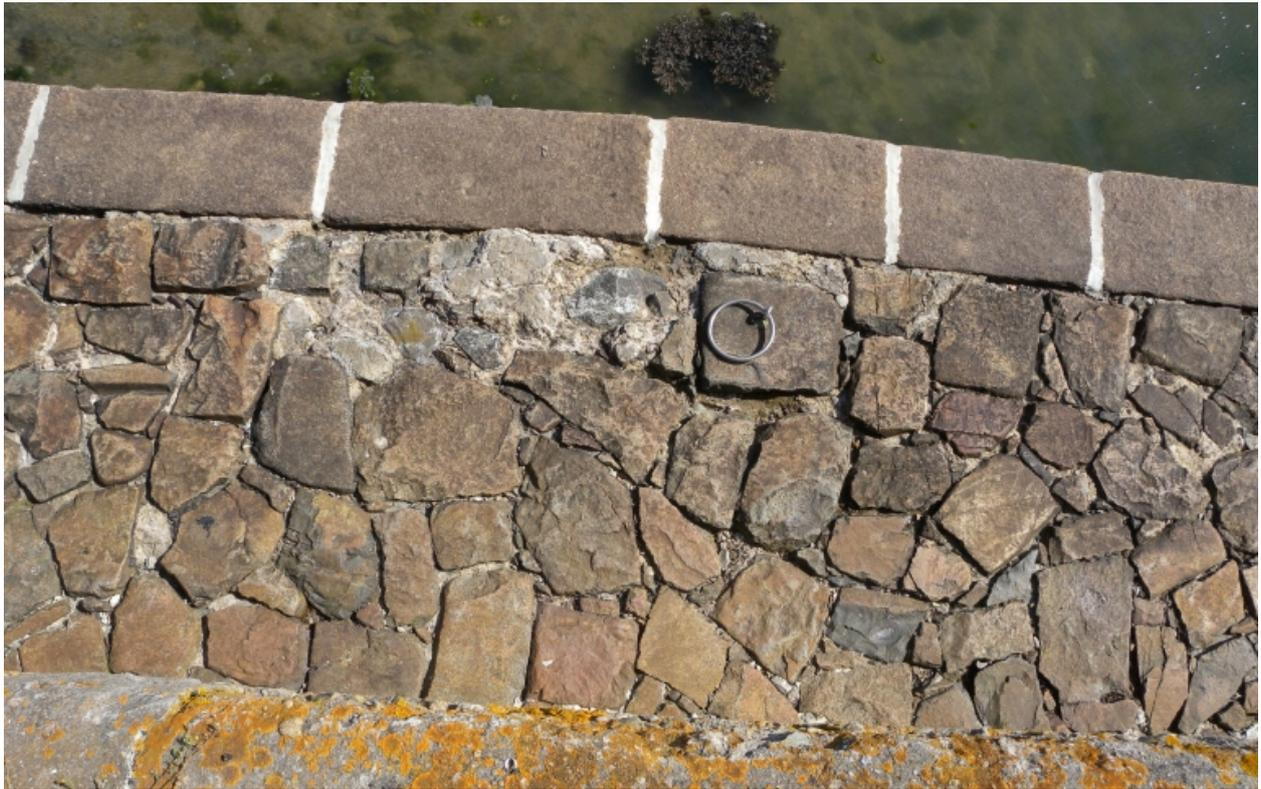
Vue du recouvrement de la cale en moellons et du couronnement en pierre de taille
