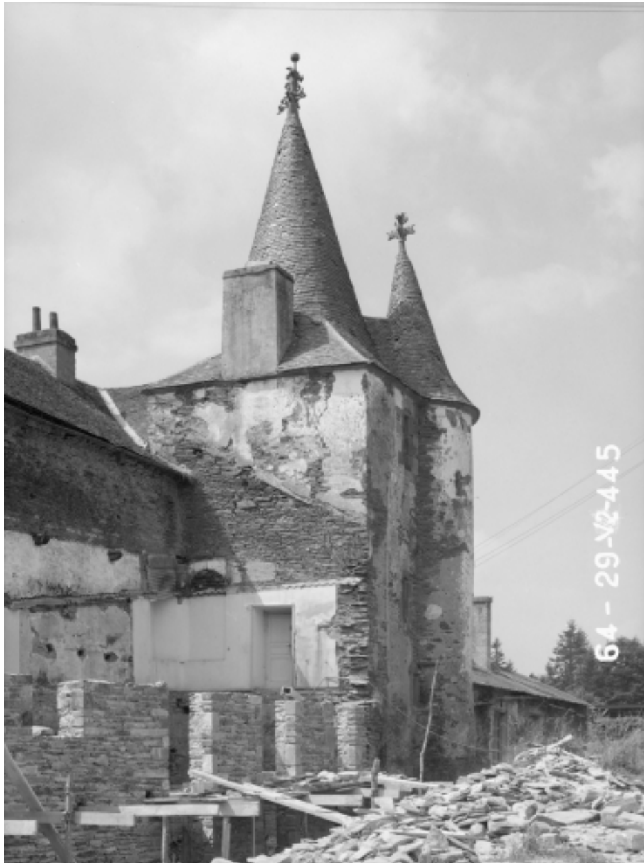
Pavillon d'escalier, vue générale
