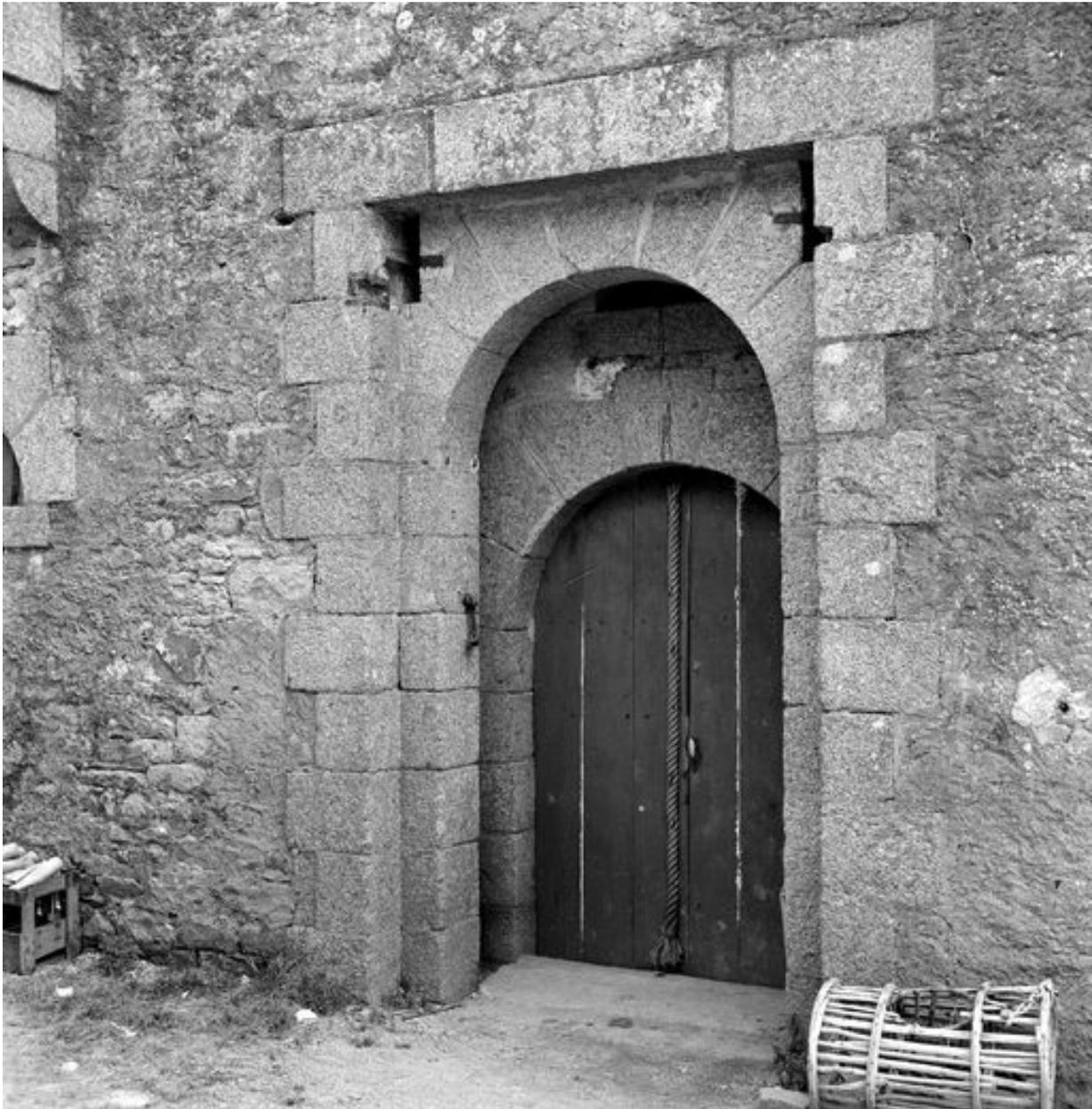
Vue du corps de garde crénelé n° 3 du bourg de Roscanvel en 1969 : porte d'entrée. A noter : la feuillure d'encastrement du pont-levis et le passage des chaînes de manoeuvre
