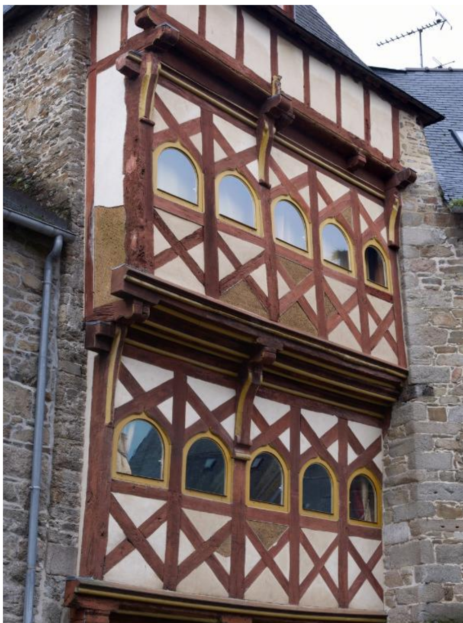
Façade sur rue. Détail des étages en encorbellement avec petites baies en continue soulagées par un contreventement en croix de saint André sous l'allège
