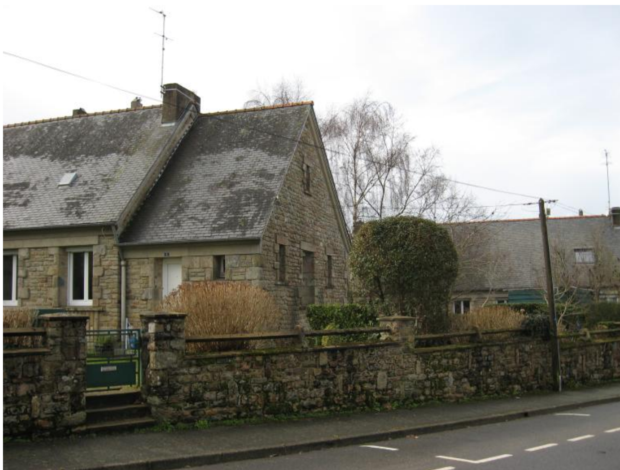
Cité des cheminots, maison vu de l'avenue du 8 Mai 1945
