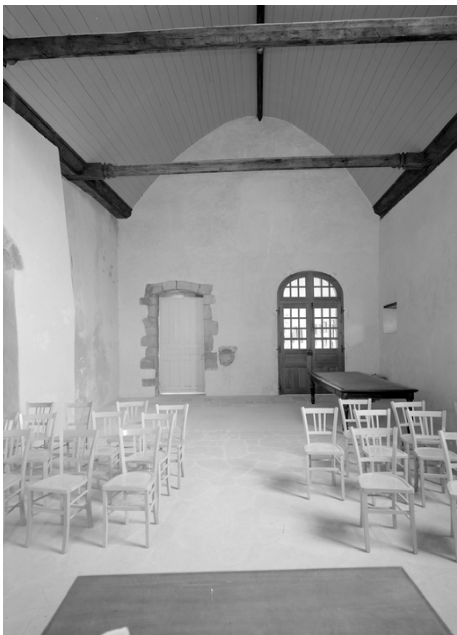
Chapelle, deuxième niveau, vue vers l'ouest.
