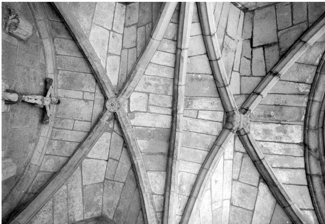
Porche : vue de la voûte
