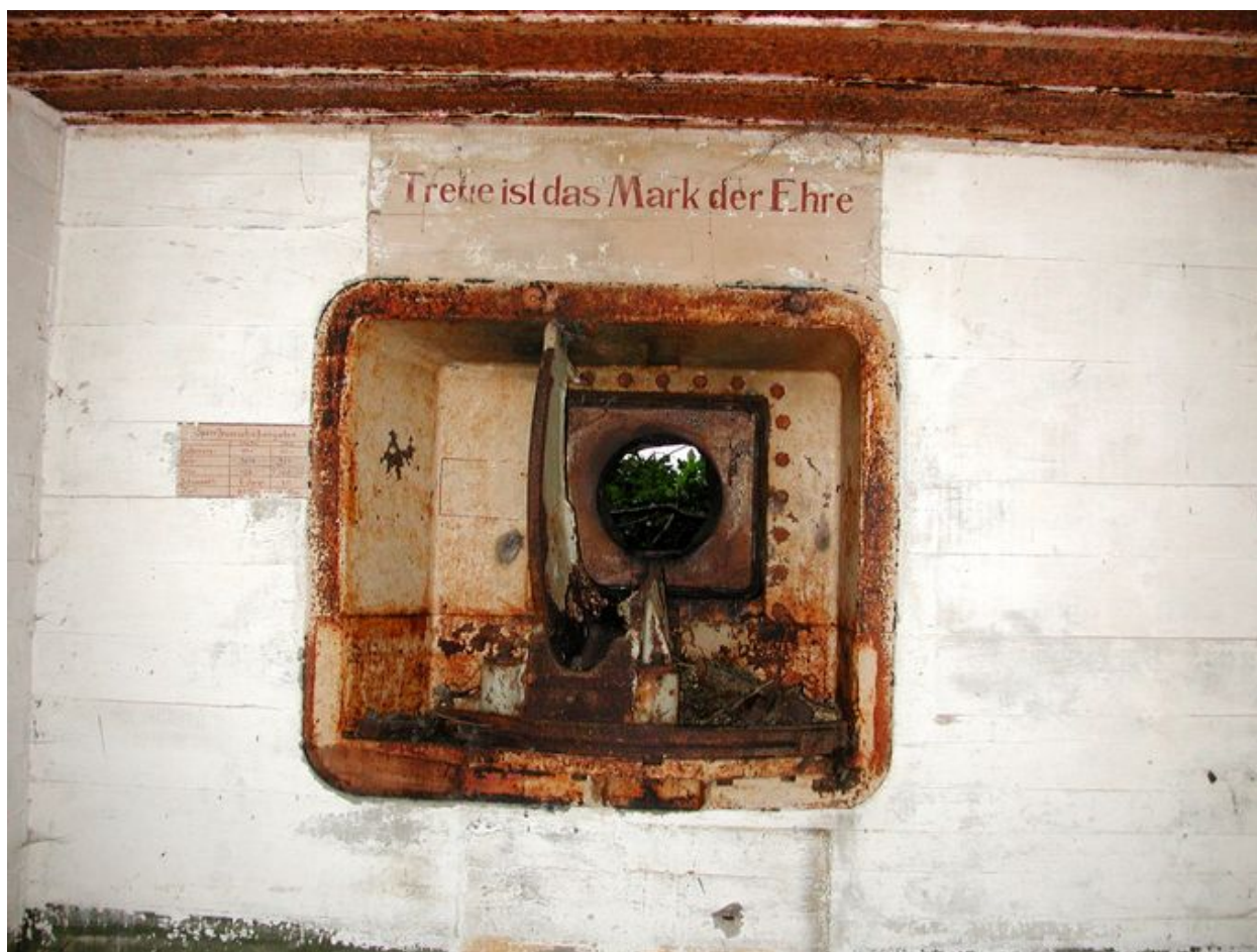
Vue de la casemate de type Vf pour canon de 47 mm Skoda de la ligne de défense terrestre ouest de Brest (Kervaoter) : peinture murale de propagande
