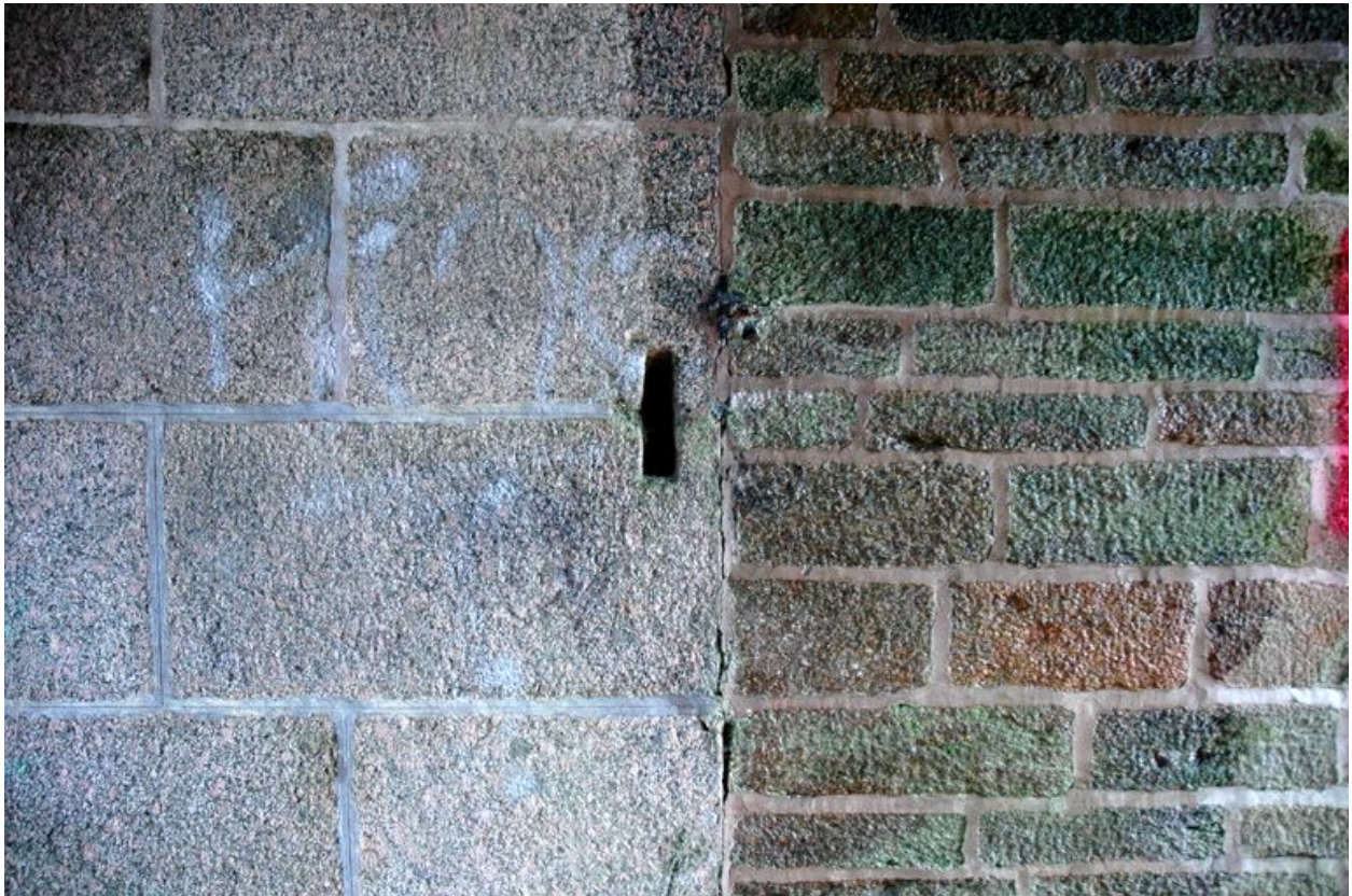
Vue de détail du passage d'entrée voûté en berceau : pierres de taille de granite contre moellons équarris (état en 2006)
