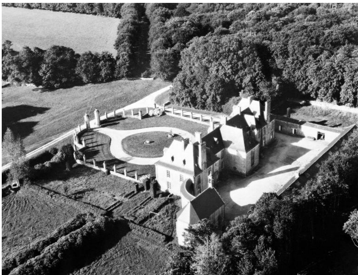
Vue aérienne nord-est
