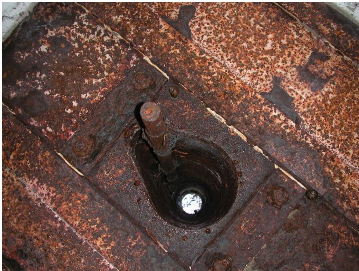
Vue de la salle de garde / pièce de vie : puits du périscopes (état en 2002)
