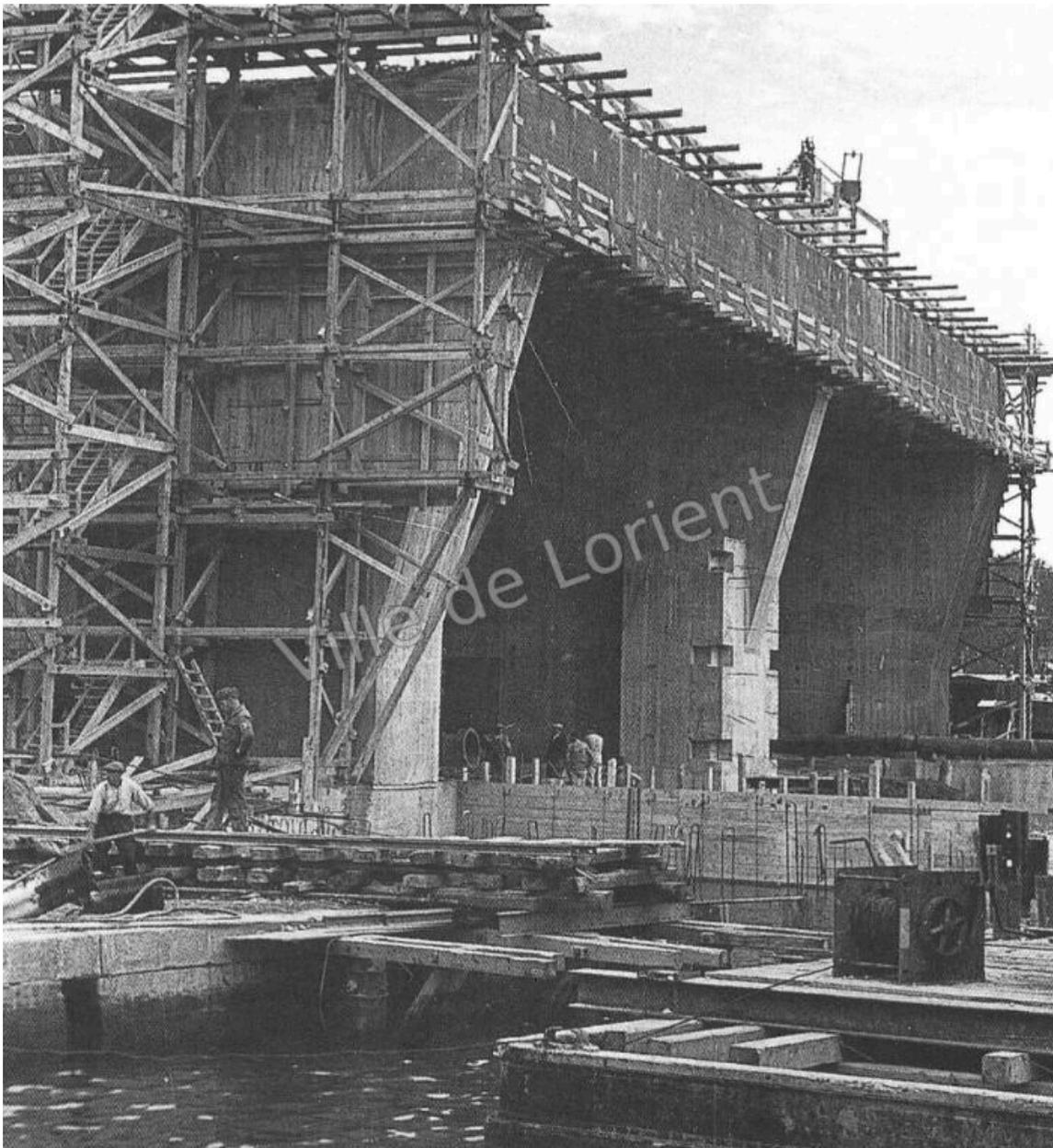
Vue de la construction, vers août 1941. Les échafaudage en bois sont en place. Quelques ouvriers travaillent sur le chantier
