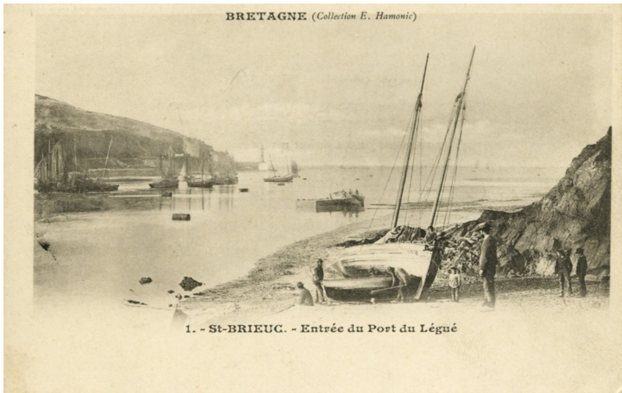
Carénage de bateaux de pêche gréés en lougre, rive droite de l'avant-port, en 1902 (AD 22)
