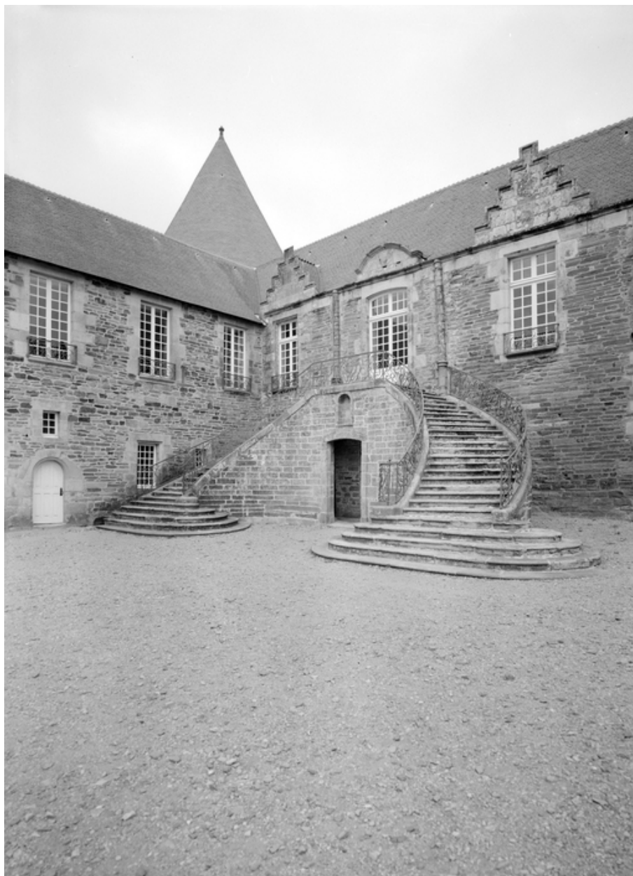
Escalier à l'angle nord-ouest de la cour.
