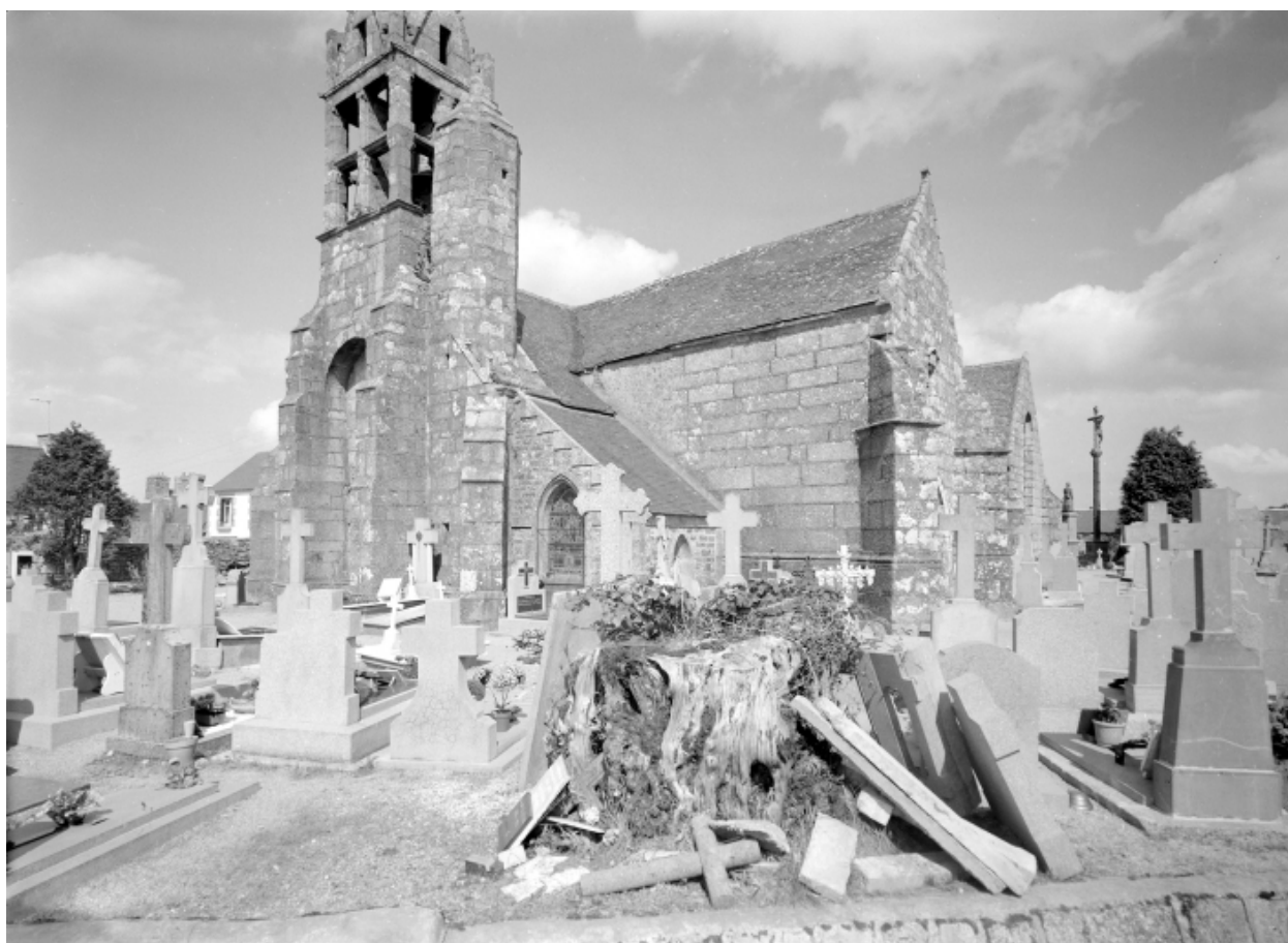
Vue prise du sud-ouest
