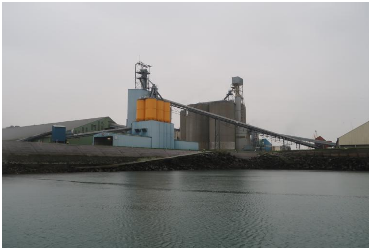
Partie nord du 6e bassin : perré, cale, silos, hangars (magasin T), bandes transporteuses, usine de trituration
