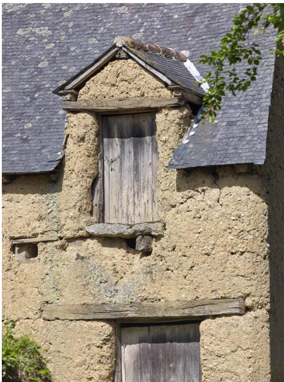
Lucarne élevée en terre
