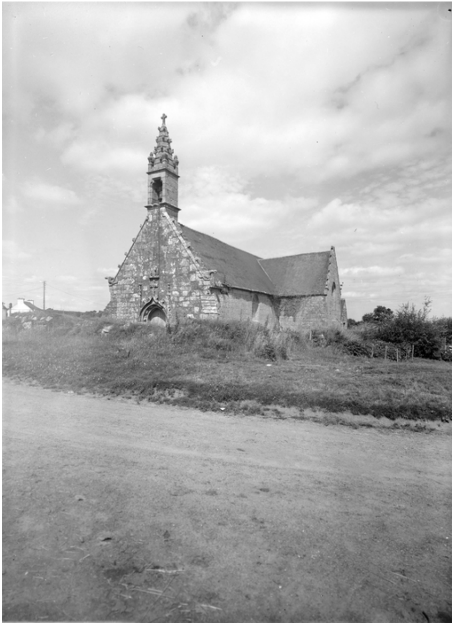
Face sud-ouest : vue générale
